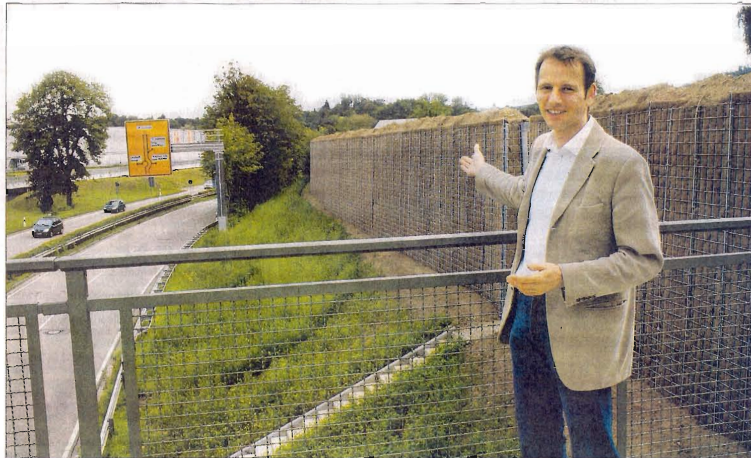
DIE NEUE LÄRMSCHUTZWAND zwischen der B 500 und dem künftigen Wohngebiet Bretagne ist fertig. Nach Auskunft von Alexander Wieland, dem technischen Projektsteuerer bei der Entwicklungsgesellschaft Cité, hat die Konstruktion aus Naturmaterialien Modellcharakter in der Region. Foto: Rudolphi
