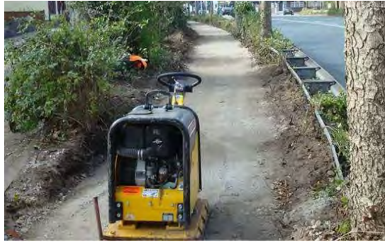
Gründung mit Schottertragschicht
