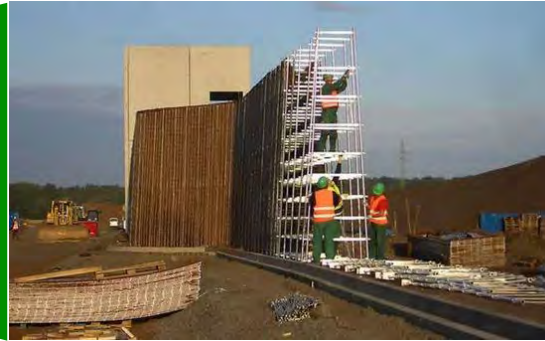
Stahlgerüst aufstellen auf die Tragschicht
