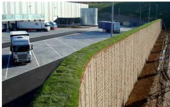
Abschluss oben mit einer Rasenkrone
