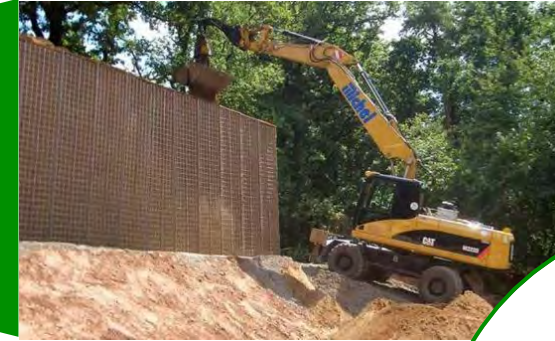
Verfüllung , Boden- oder Restmaterial
